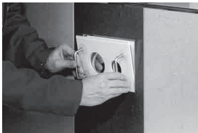
Paigalduskomplektis on käepidemed nupu demonteerimiseks.
